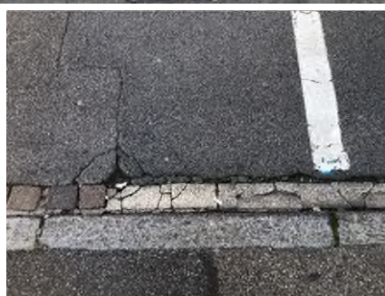
Abb. 1: Dorfstrasse weist Belagsschäden wie Querrisse, offene Nähte und Spurrinnen auf
