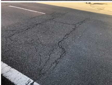
Abb. 1: Dorfstrasse weist Belagsschäden wie Querrisse, offene Nähte und Spurrinnen auf
