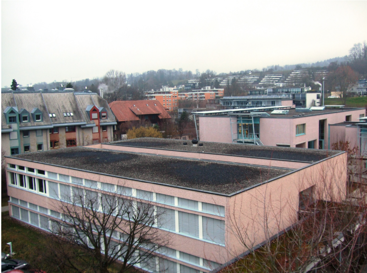
Abb. 4: Blick aus Südosten auf den bestehenden Spezialtrakt
