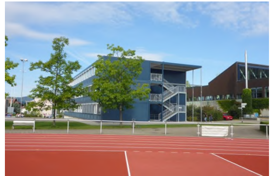
Abb. 2: ... und nach der Aufstockung
