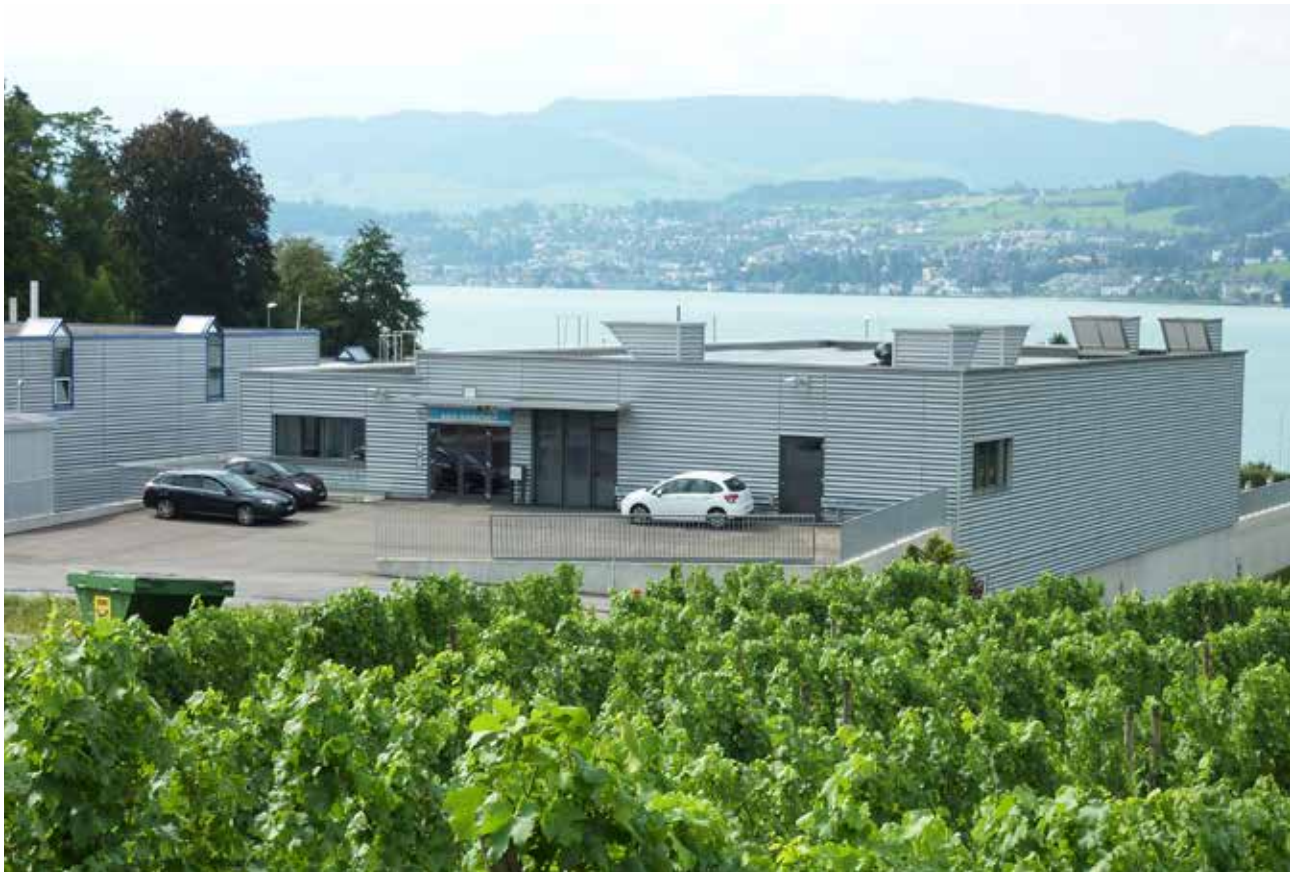
Abb. 2: Im obersten Geschoss befinden sich die Büroräume und die Betriebsleitzentrale.
