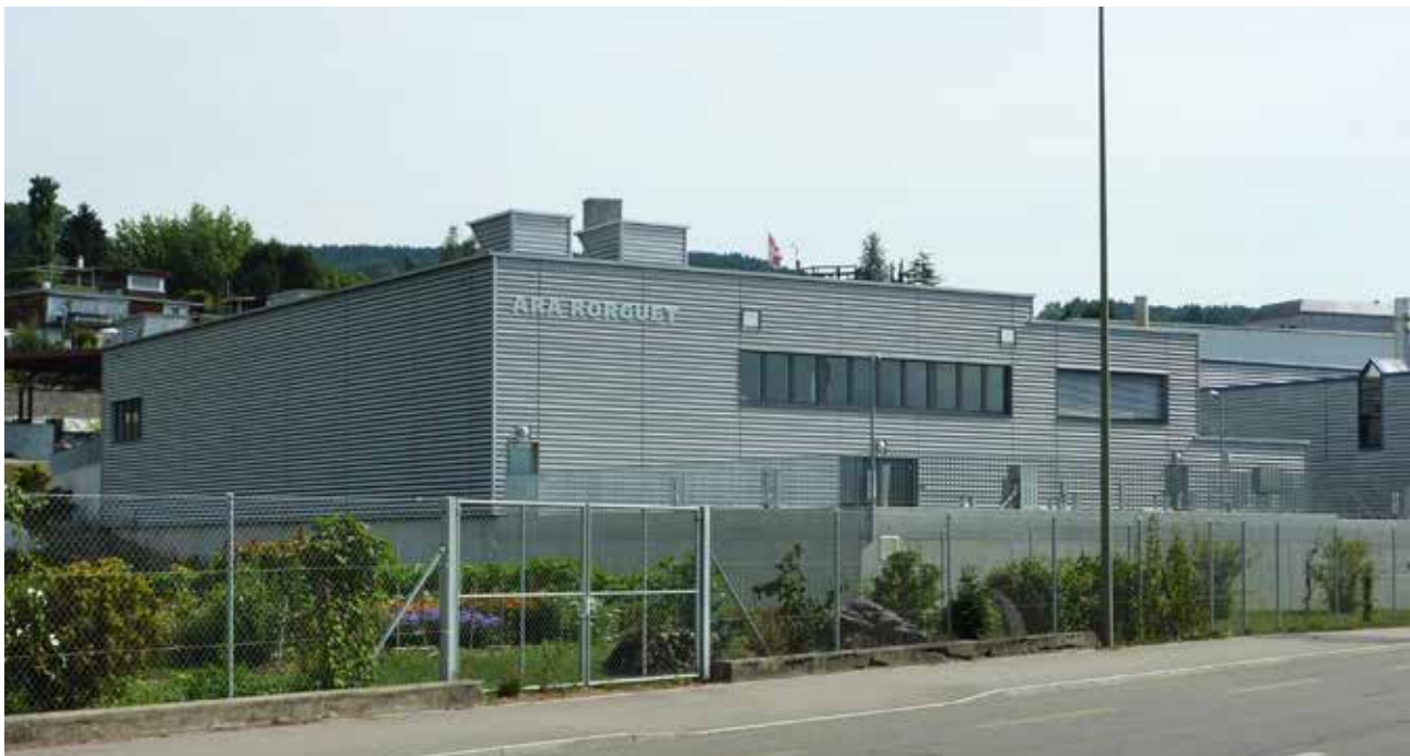
Abb. 1: Das neue Biofiltrationsgebäude der ARA Rorguet bildet mit dem Werkhof zusammen eine architektonische Einheit.
