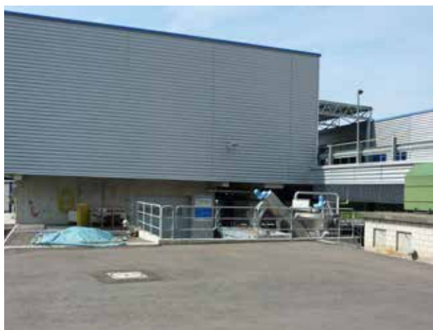
Abb. 2: Nordfassade der Werkhalle mit Verbindungsdach zum Werkhof.
