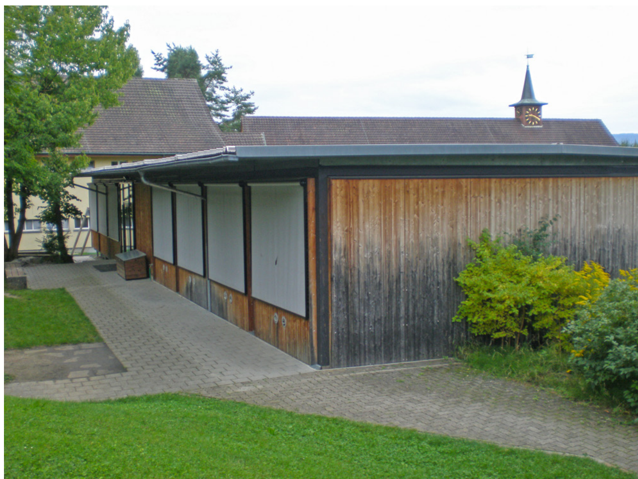
Abb. 6: Bestehender «Züri-Modul»-Pavillon II in Feldmeilen
