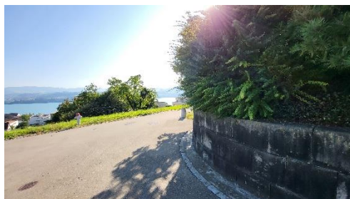
Einmündung Kübler-Ross-Strasse : Sichtweite eingeschränkt
