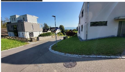
Einmündung Plattenstrasse: Sichtweiten i.O.
