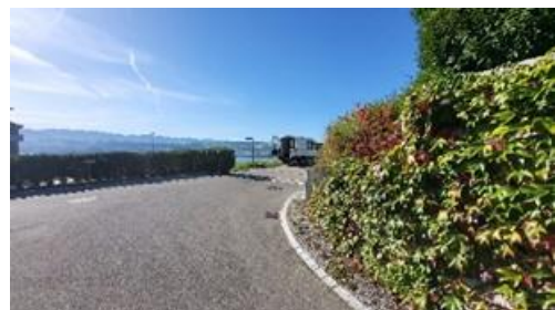
Verzweigung Höhe Wetzwillerweg: Sichtweite eingeschränkt
