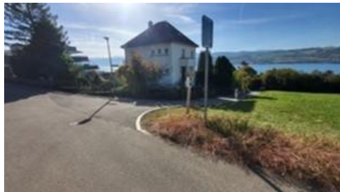
Einmündung Raingässli: Sichtweite i.O.
