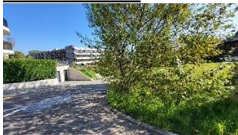
Einmündung Plattenstrasse: Sichtweite durch Bepflanzung eingeschränkt
