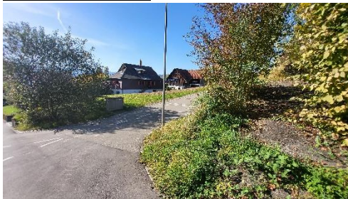
Einmündung Kübler-Ross-Strasse: Sichtweite eingeschränkt
