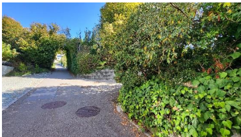
Einmündung Durstrasse: Sichtweite eingeschränkt
