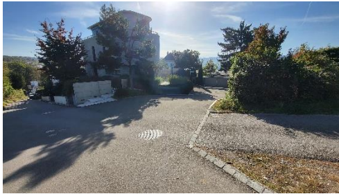
Einmündung Raingässli; Sichtweite eingeschränkt
