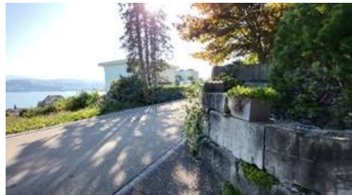
Private Liegenschaften (Beispiel): Sichteinschränkungen durch Einfriedungen
