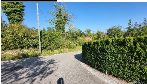
Einmündung Luftstrasse: Sichtweite eingeschränkt
