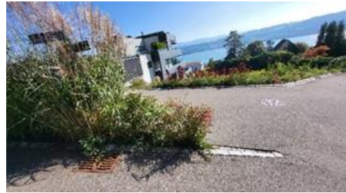
Einmündung Wendeplatz Durststrasse: Sichteinschränkungen durch Bepflanzung
