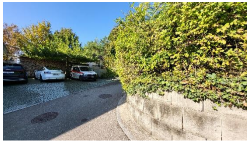
Einmündung Raingässli: Sichteinschränkung durch Einfriedungen
