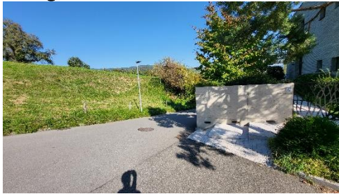
Einmündung Luftstrasse: Sichtweite eingeschränkt
