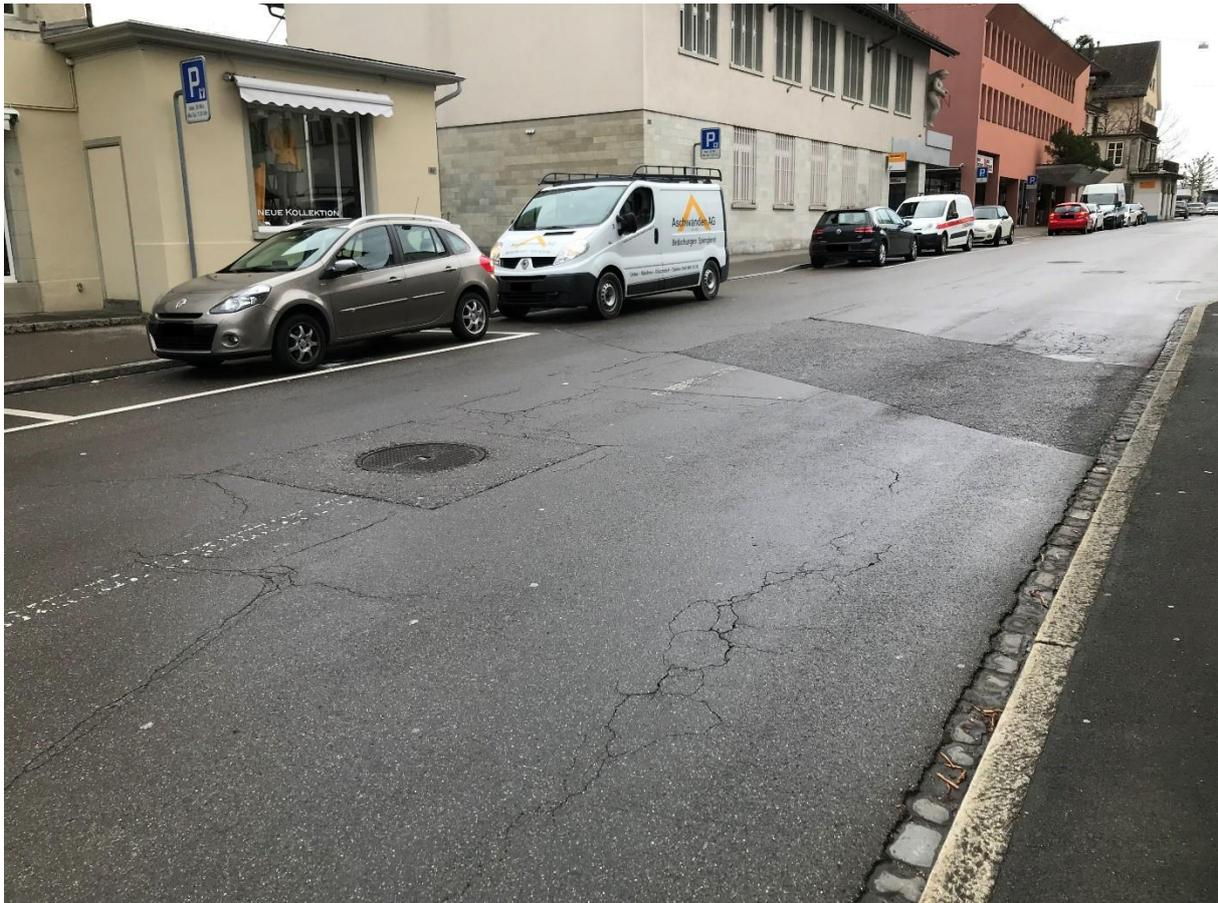
Abb. 1: Dorfstrasse weist Belagschäden wie Querrisse, offene Nähte und Spurrinnen auf
