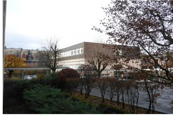
Abb. 2: ... und nach der Aufstockung
