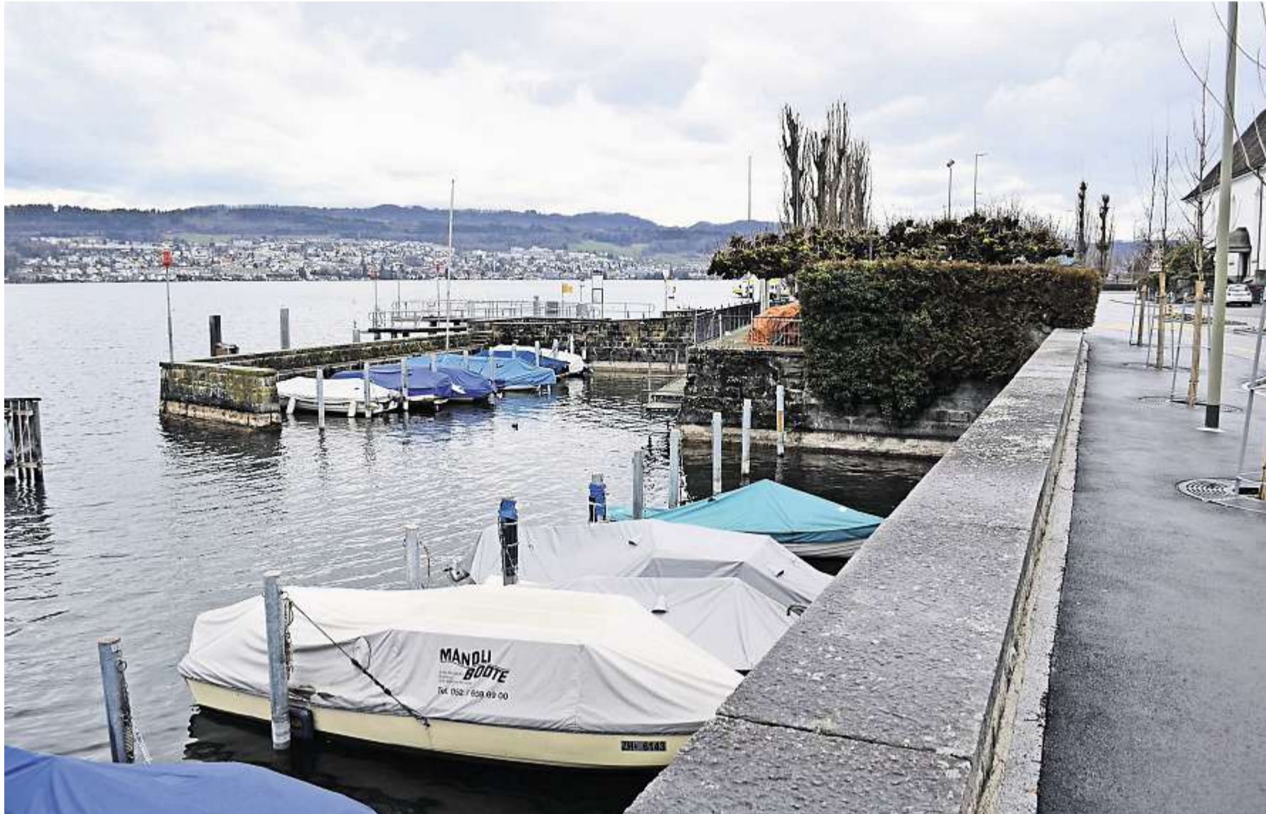
Beim Hafen neben der Sommerterrasse des Restaurants Löwen (hinter der Hecke) werden die Rohre im See verlegt. Bild: Frank Speidel
