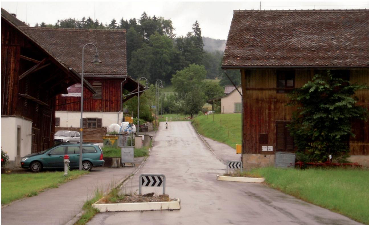
Abb. 2: Die stark beschädigte Burgstrasse mit den provisorischen Verkehrsberuhigungsmassnahmen.
