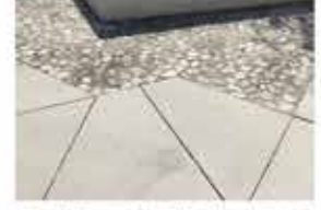
Zwischenbau mit Mauerwerksteinen und Naturgerundete Natursteinen
