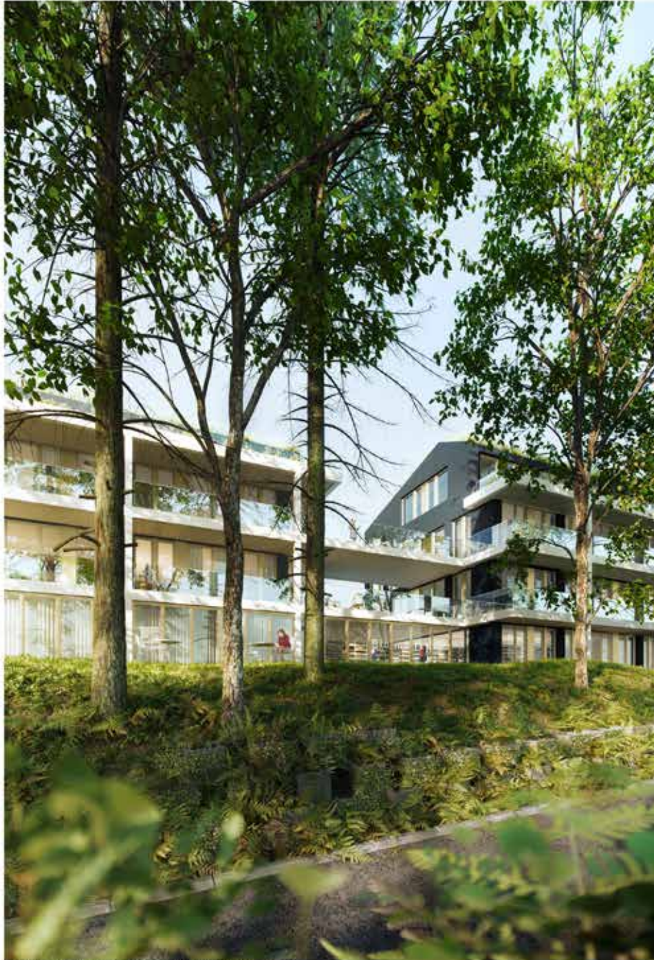
Blick über die Döllkerstrasse hinweg auf die im Quartier präsentesten Gebäude
