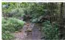
Oben: Bachtrasse als Hang Unten: horizontaler Bachlauf
