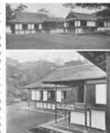
Unterschiedliche Dachformen in Wädswil sind die historische Referenz für die architektonische Struktur des Projektes, hier die Katsura-Familie.
